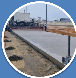
Строительство путепровода-дублера ул. Якубовского- Загородное шоссе в г. Могилеве (II очередь)
