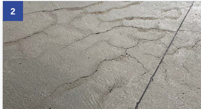
Усадочные трещины
