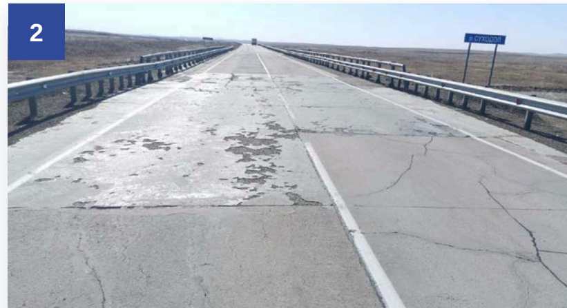
Шелушение покрытия
