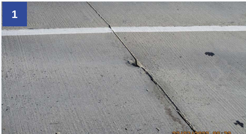
Выкрашивание герметика
