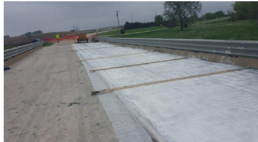
Вся площадь закрыта защитной пластиковой пленкой
