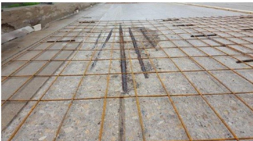
Один слой сетки над опорами
