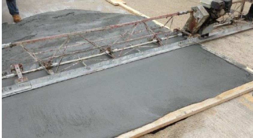
Укладка смеси с помощью виброрейки
