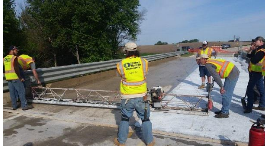
Установка виброрейки для работы на правой стороне
