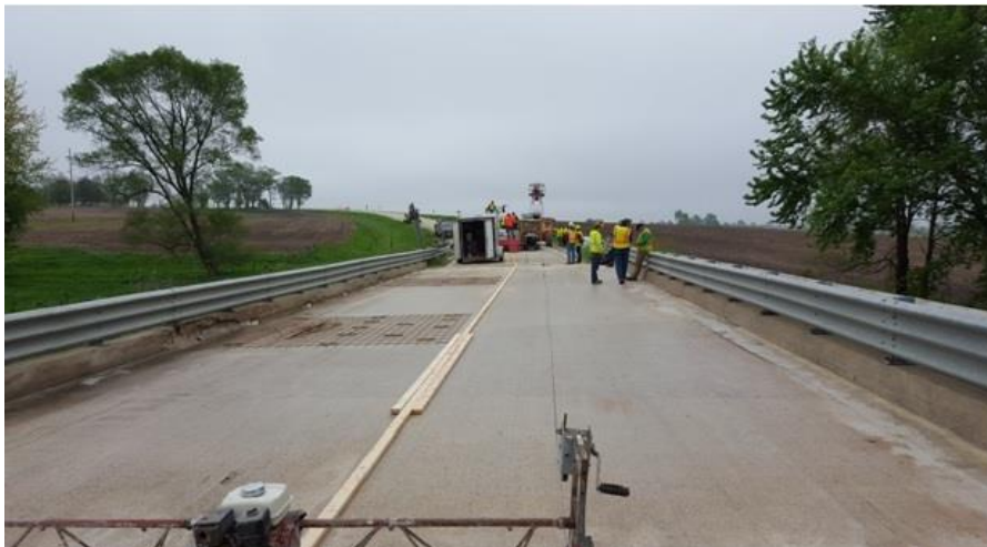
Поверхность готова для нанесения добавленного слоя
