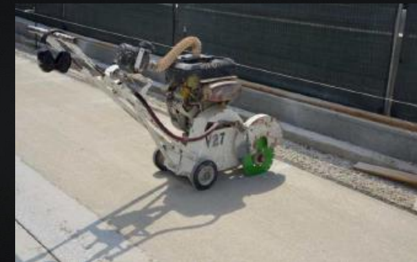
Инициирование трещин в НАЦП
