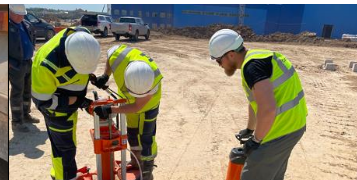
Отбор и испытания кернов
