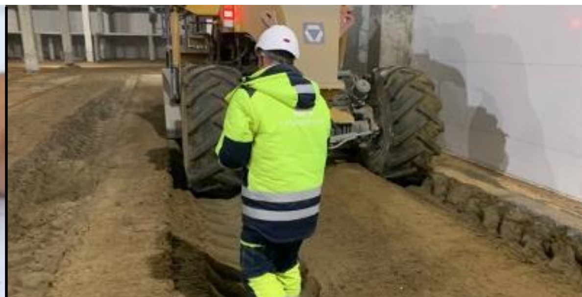
Техническая поддержка при пуско-наладочных работах
