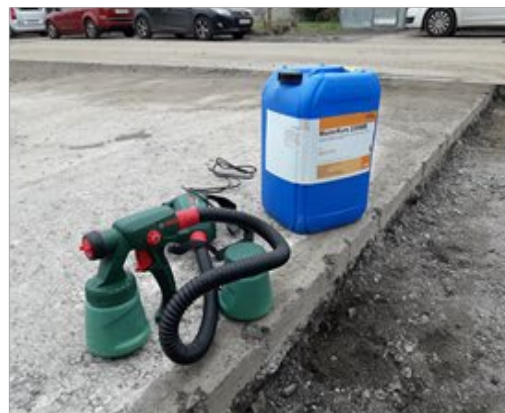
Нанесение защитного покрытия (кьюринг)
