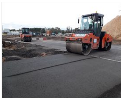
Уплотнение бетонной смеси катками
