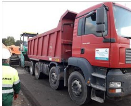
Доставка бетонной смеси на объект
