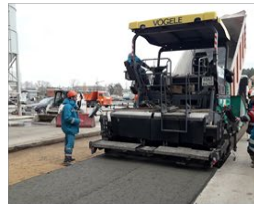
Укладка бетонной смеси асфальтоукладчиком
