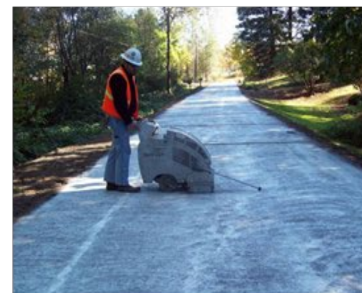
Нарезка деформационных швов
