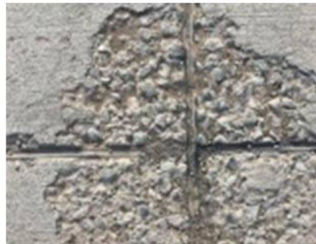
Шелушение и разрушение кромки
