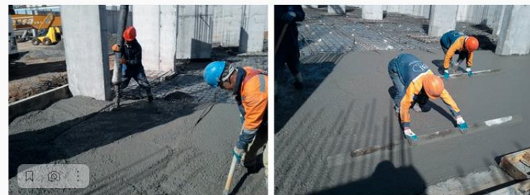
а) Подача бетона автобетононасосом б) Укладка бетона без виброуплотнения
