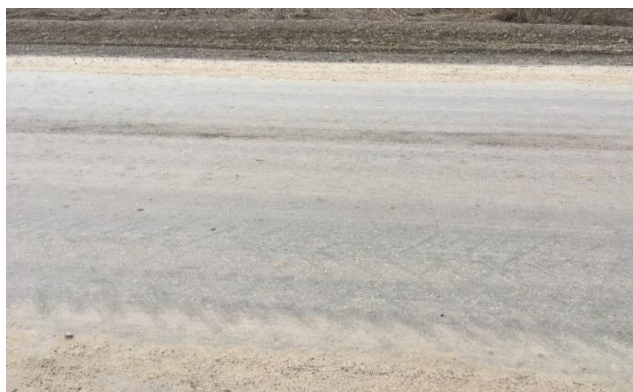
Основание, регенерированное с комплексным минеральным вяжущим
