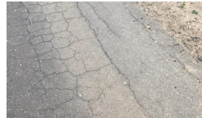
Отраженные трещины на асфальтобетонном покрытии через 1 год эксплуатации
