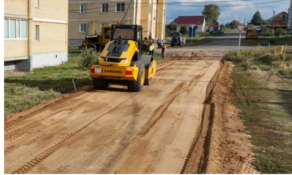
Уплотнение слоя основания
