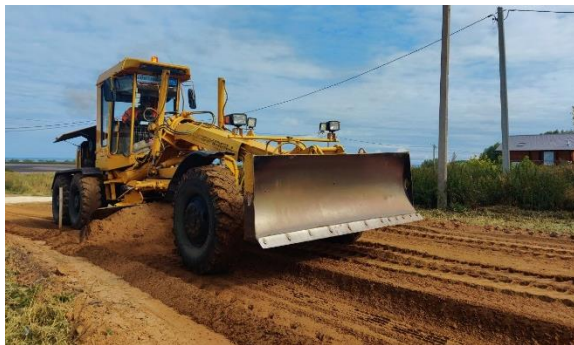
Подвоз и распределение грунта
