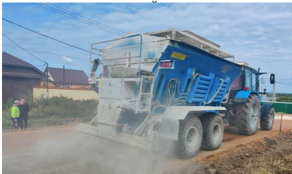
Распределение цемента цементораспределителем
