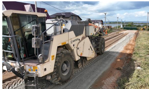
Перемешивание компонентов ресайклером
