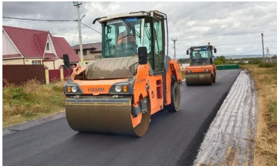
Укладка верхнего слоя покрытия
