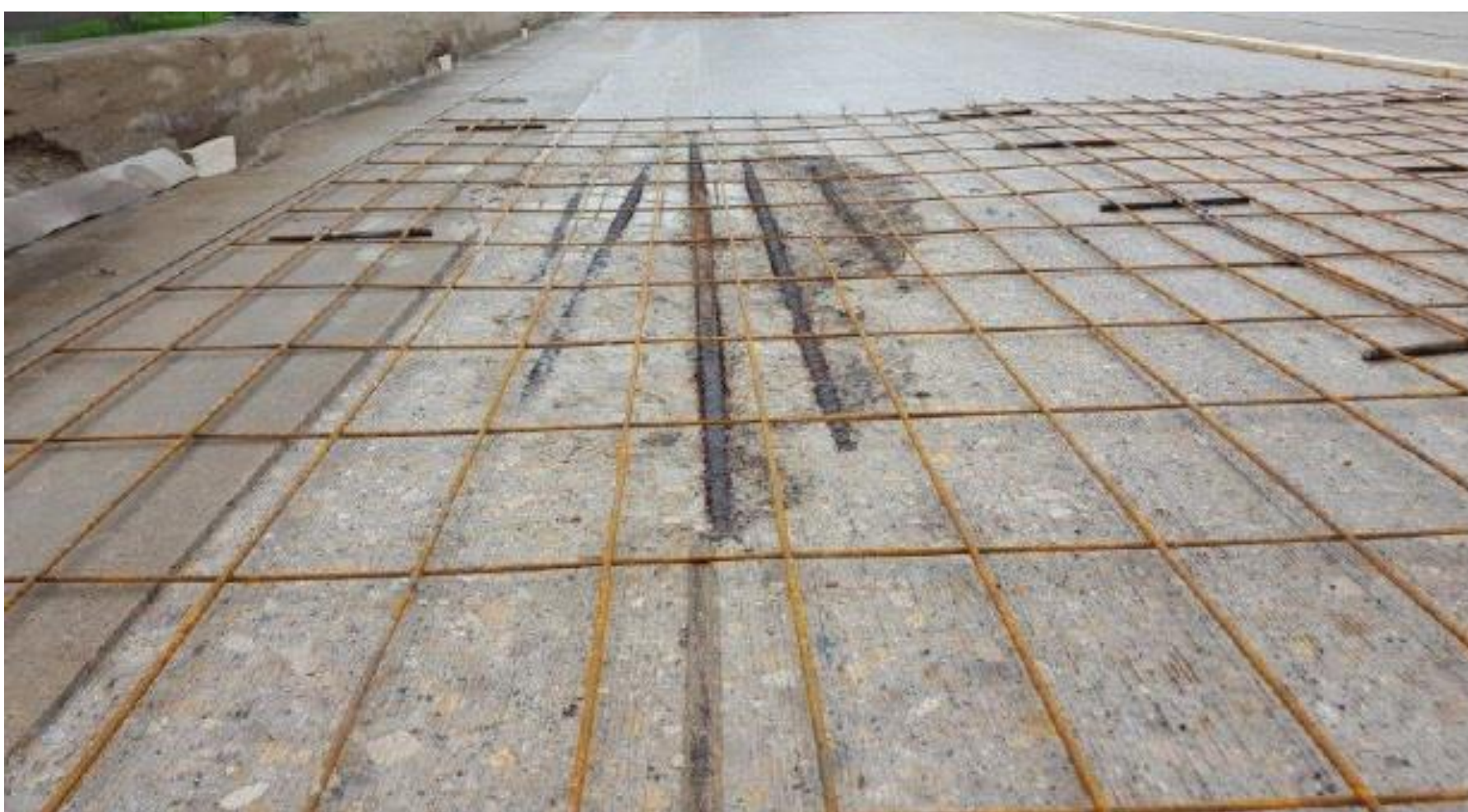
Дополнительное армирование над опорами
