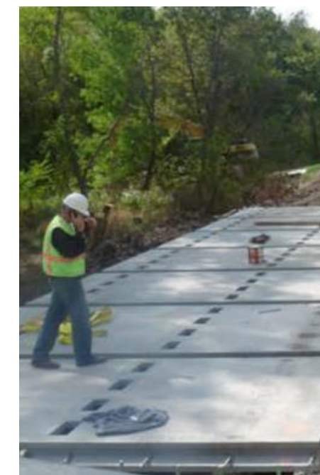
Плиты «вафельного» типа
