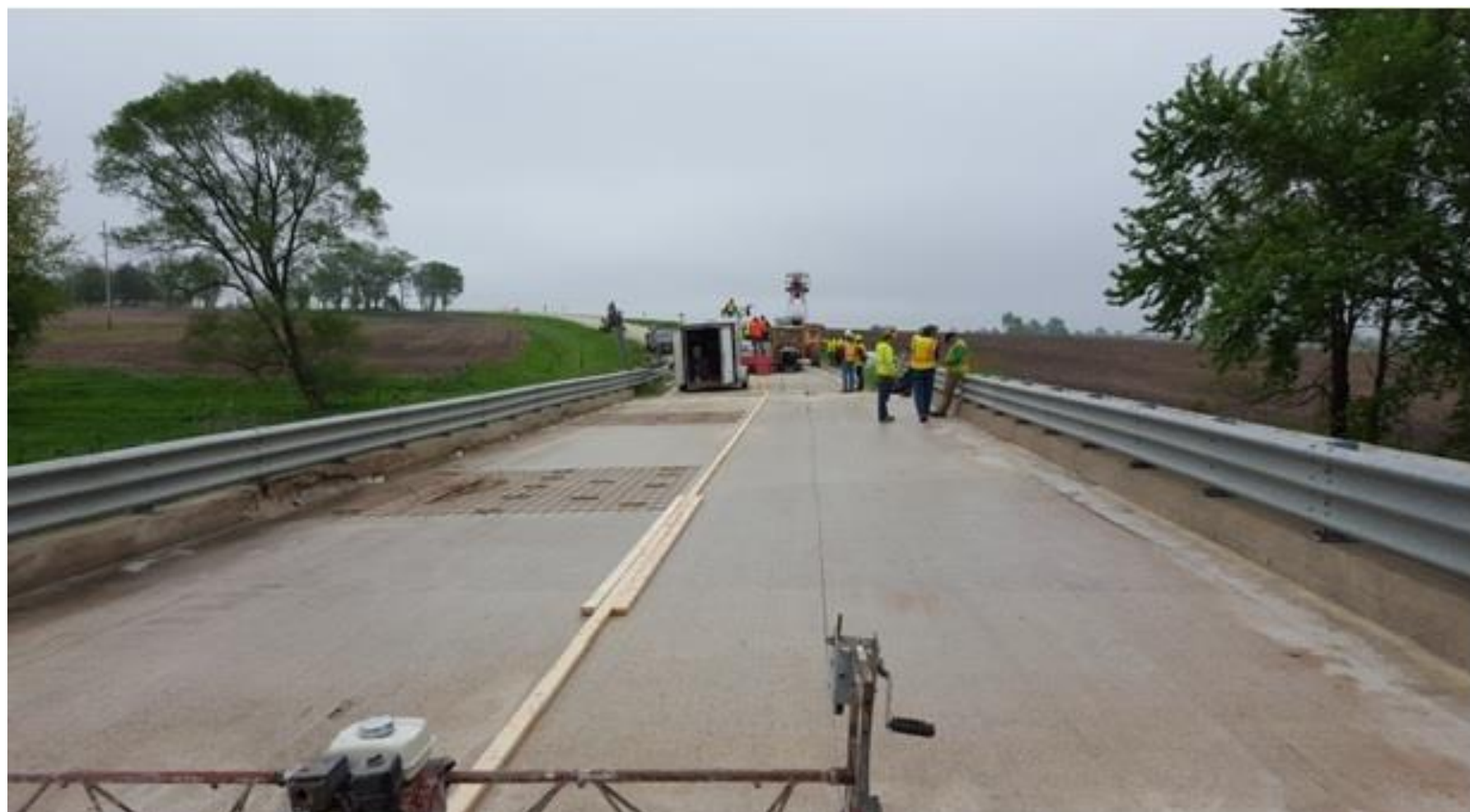
Поверхность готова для нанесения СПФБ
