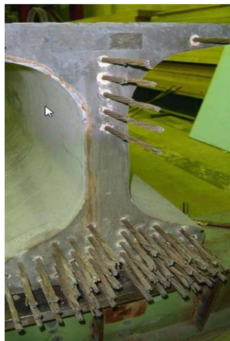
Балки пролетных строений
