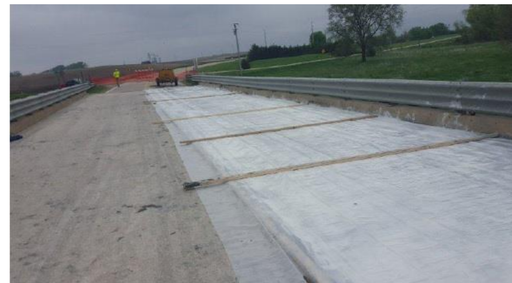
Вся площадь закрыта полиэтиленовой пленкой
