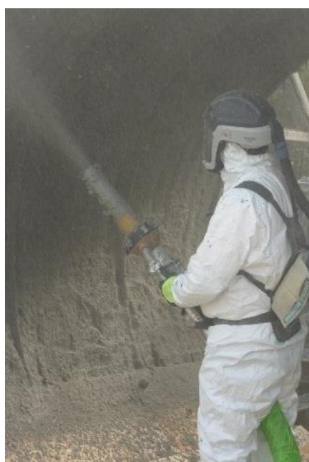
Ремонт труб и коллекторов
