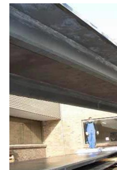
Элементы несъемной опалубки
