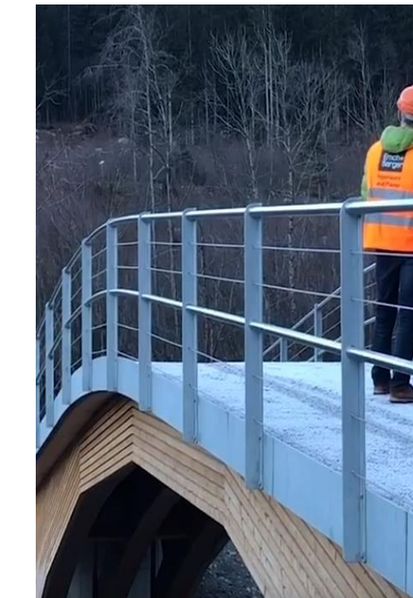
Плита деревянного пролетного строения
