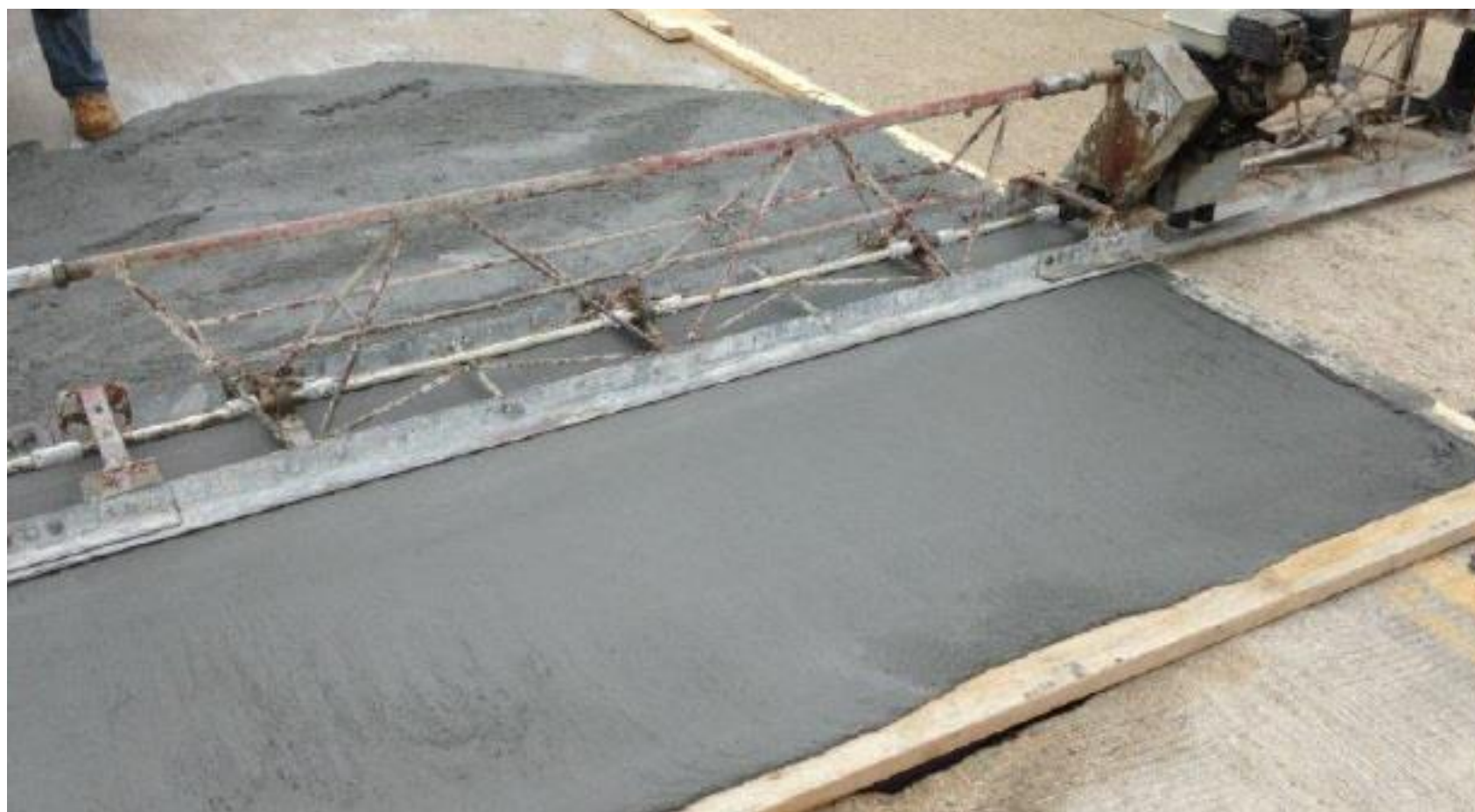
Укладка смеси с помощью виброрейки
