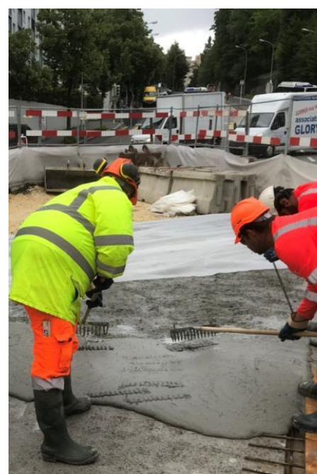
Гидроизоляция и ремонт плит проезжей части
