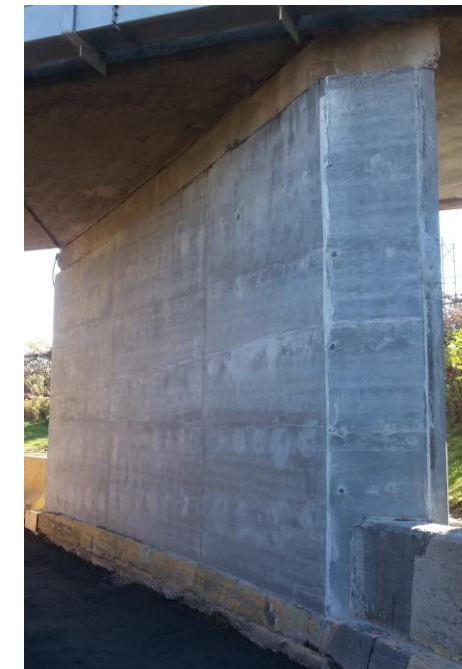
Защита и усиление опор
