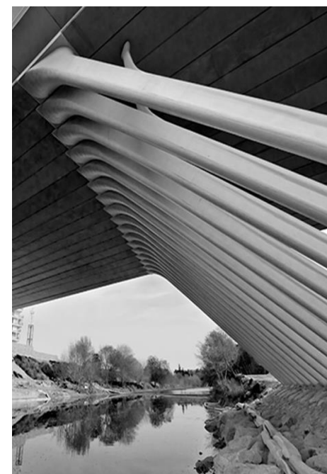
Сваи и элементы опор
