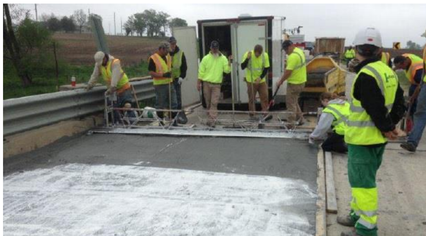
СПФБ уложен по всей первой полосе, защита поверхности
