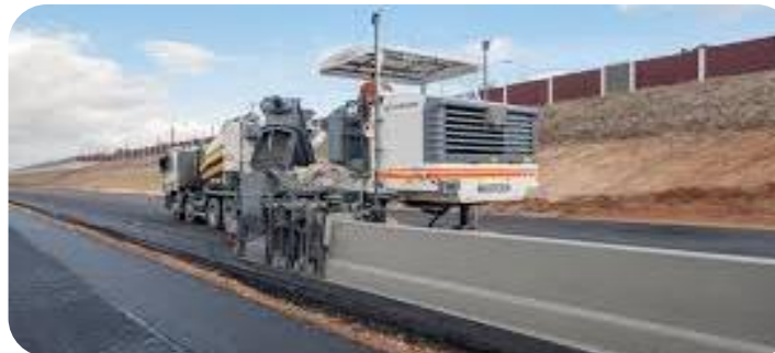
Монолитные парапетные ограждения с использованием скользящих форм
