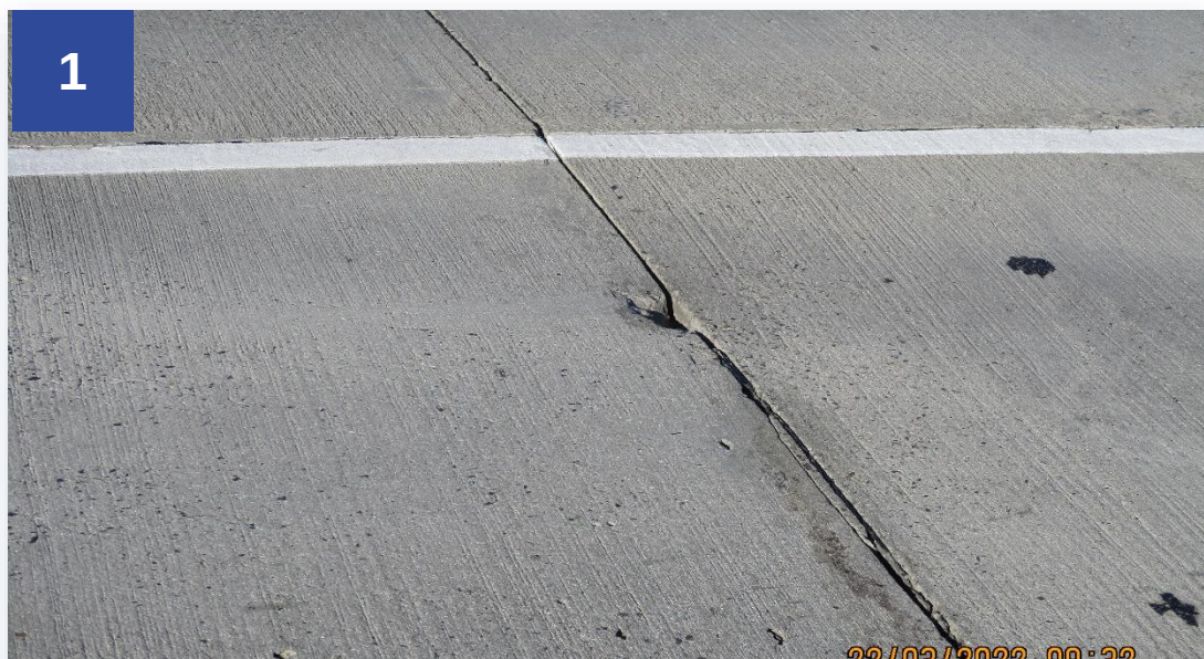
Выкрашивание герметика
