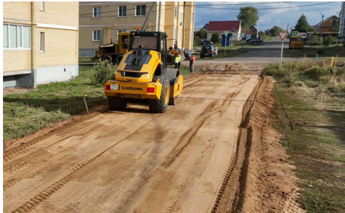
Уплотнение слоя основания
