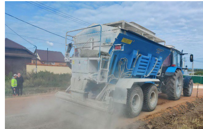
Распределение цемента цементораспределителем
