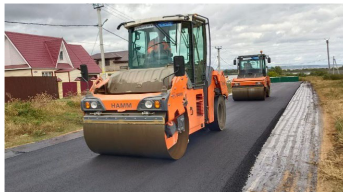
Укладка верхнего слоя покрытия
