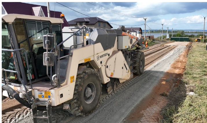
Смешение цементогрунта ресайклером с увлажнением и введением водорастворимых модификаторов
