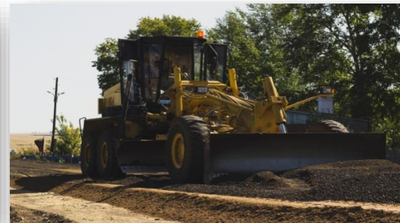
Распределение асфальтогранулята автогрейдером
