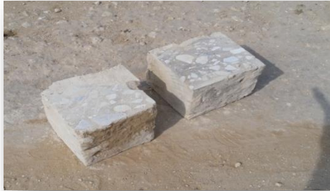
Образец-кern из покрытия экспериментального участка автомобильной дороги
