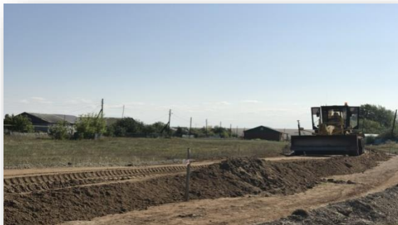
Распределение грунта автогрейдером
