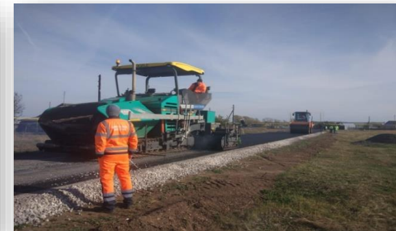
Укладка асфальтобетона
