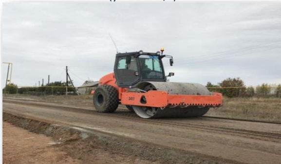
Уплотнение готовой смеси
