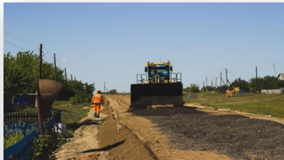
Подвоз асфальтогранулята погрузчиком
