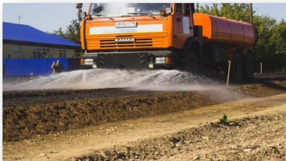
Розлив воды поливмоечной машиной (раствор гидрофобизатора для участка 1)
