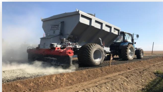
Распределение цемента цементораспределителем
