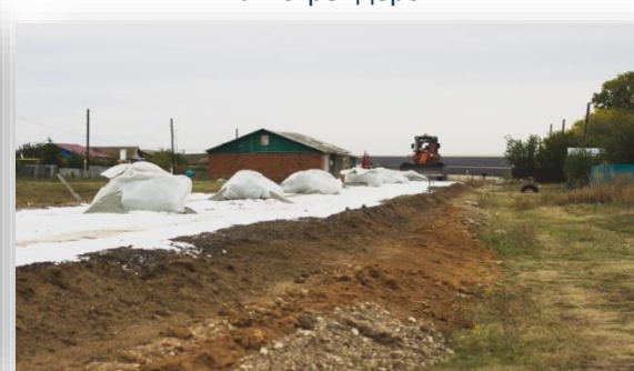
Распределение фиброволокна автогрейдером (участок 2)
