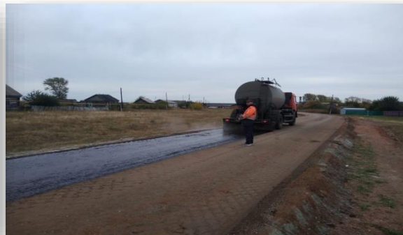
Розлив битумной эмульсии автогудронатором
