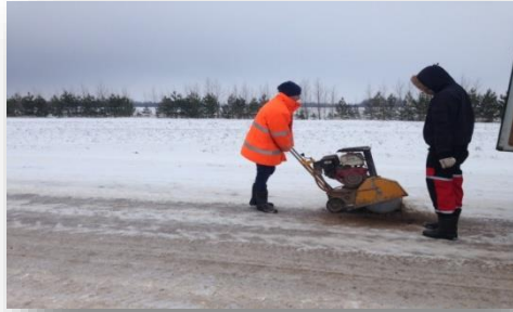
Отбор проб с экспериментальных участков автомобильной дороги
