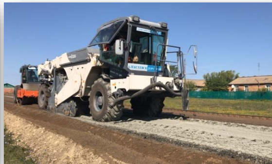
Смешение компонентов ресайклером с последующим уплотнением катком
