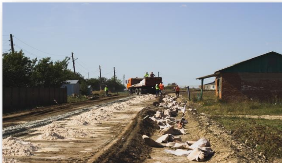
Внесение активированных минеральных наполнителей, распределение автогрейдером (участок 3,4)
