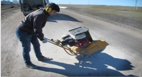
Отбор проб с экспериментальных участков автомобильной дороги
