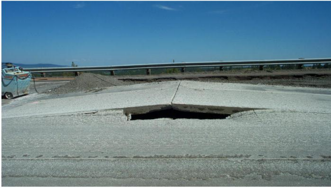
Потеря продольной устойчивости дорожного покрытия со значительным разрушением бетона в окрестности поперечного шва
