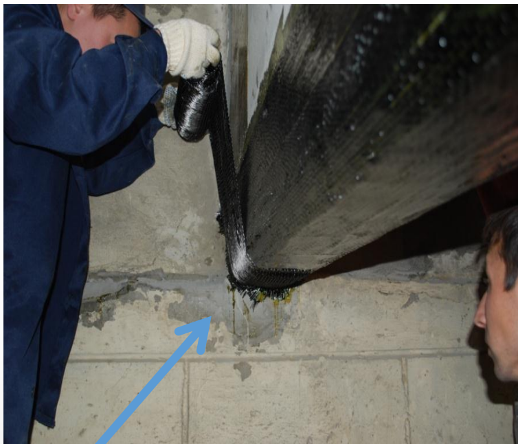
АРМИРОВАНИЕ БАЛКИ МОСТА УГЛЕРОДНОЙ ЛЕНТОЙ
