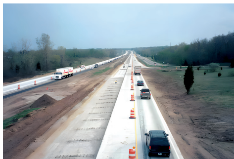
Рис. 17. Перекрывание слоем цементобетона по технологии Whitetopping на автомагистрали в США осуществляется без остановки движения транспорта
