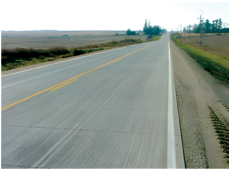
Рис. 18. Автодорога после фрезерования в штате Айова (США)
