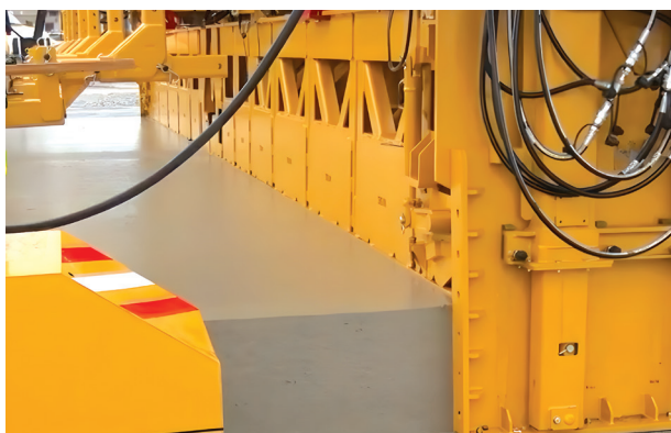
Рис. 8. Поверхность свежеложенного бетона
