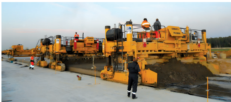
Рис. 4. Строительство цементобетонного покрытия
