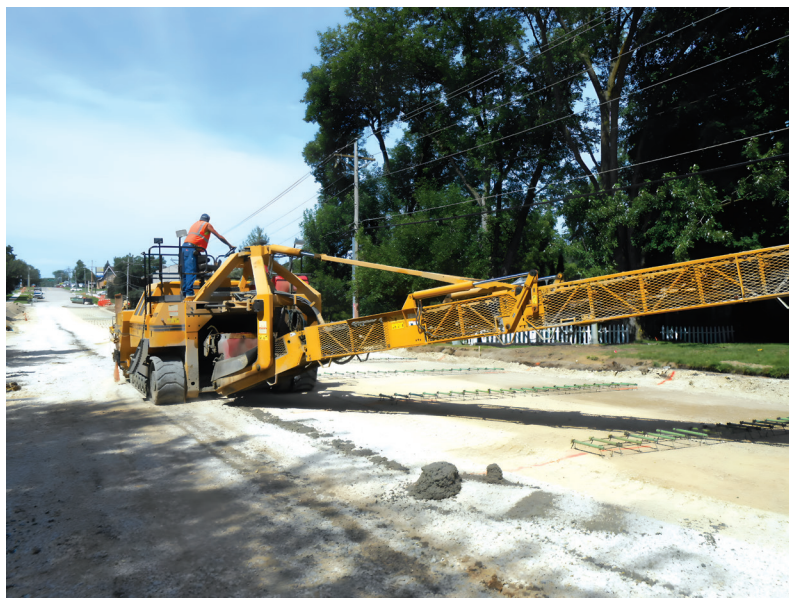
Рис. 10. Перегрузатель бетонной смеси GOMACO RTP-500 на строительстве автодороги в штате Айова (США)
