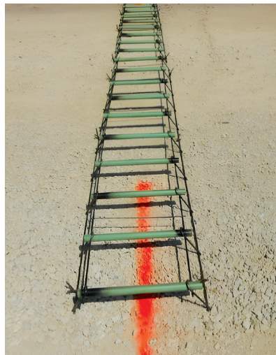
Рис. 2. Дюбели, предварительно установленные в корзины и закрепленные на основании
