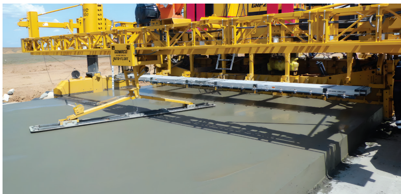
Рис. 10. Контроль геометрических параметров, ровности поверхности и качества кромки бетонного покрытия
