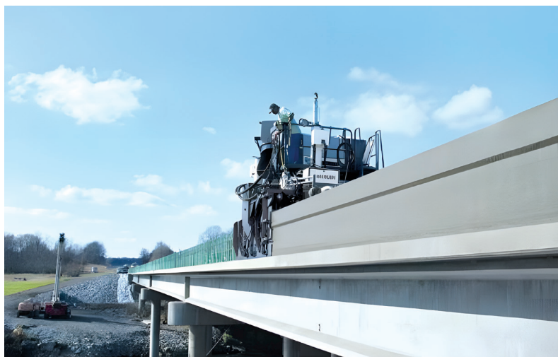
Рис. 6. Монолитные парапетные ограждения на мостовых сооружениях
