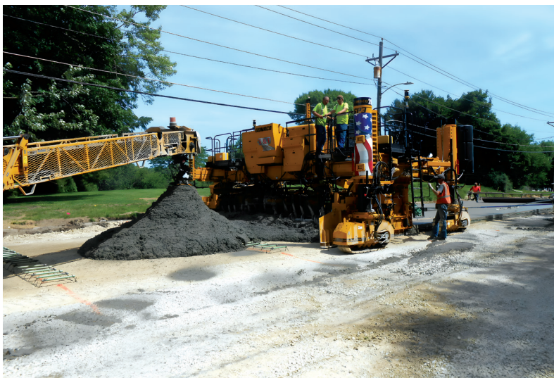
Рис. 5. Строительство автодороги с цементобетонным покрытием в штате Айова США (предустановленные дюбели в корзинах)
