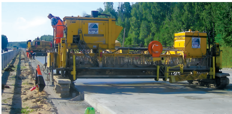
Рис. 12. Нанесение текстуры и пленкообразующего состава с помощью машины-текстурировщика
