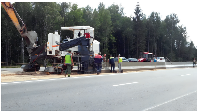
Рис. 5. Монолитные разделительные парапетные ограждения
