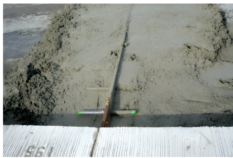
Рис. 3. Устройство шва расширения (для уплотнения бетона вдоль шва используются ручные вибраторы)
