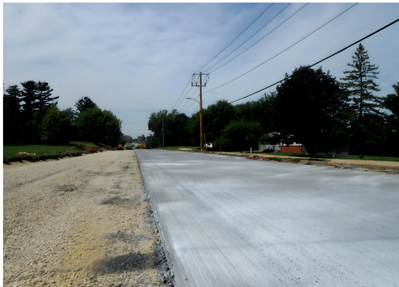
Рис. 3. Строительство автодороги с цементобетонным покрытием в штате Айова (США)
