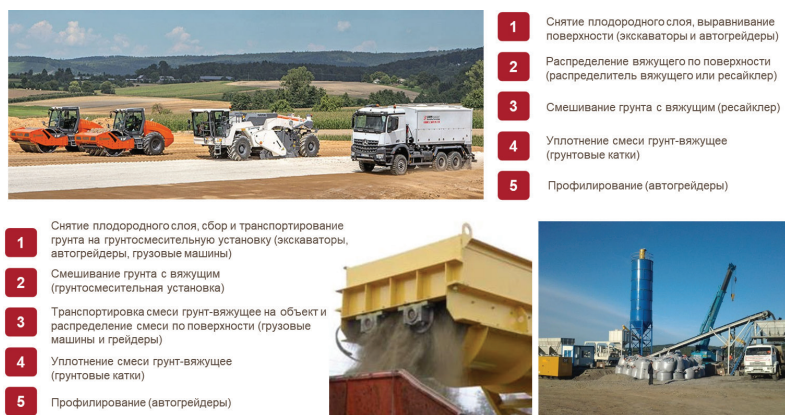
Рис. 1. Варианты технологии стабилизации / укрепления грунтов
