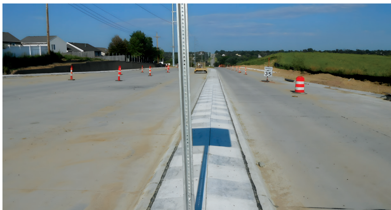
Рис. 8. Строящаяся автомагистраль с цементобетонным покрытием в штате Небраска (США)
