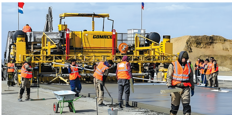
Рис. 9. Укладка бетонного покрытия с использованием скользящей опалубки
