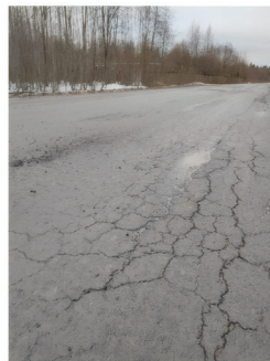
Рис. 2. Выбор технологии ремонта автомобильной дороги при разрушениях до 100 мм
