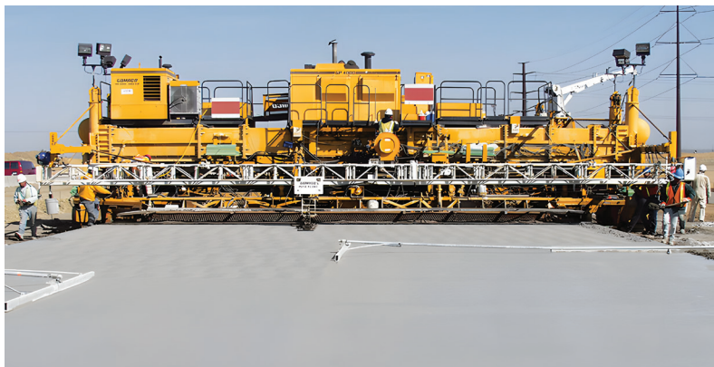
Рис. 6. Строительство междуштатной автомагистрали в штате Колорадо (США)
