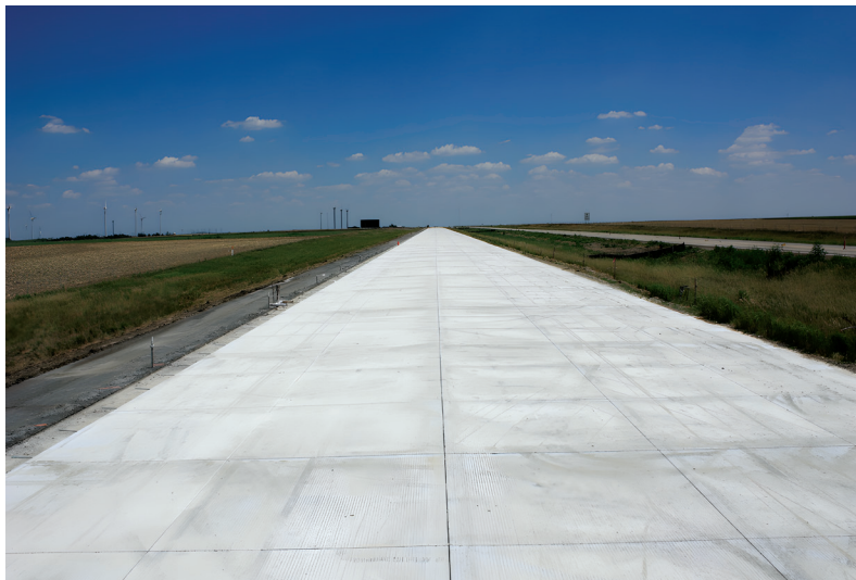
Рис. 15. Перекрытие слоем цементобетона по технологии Whitetopping автомагистрали I-70, Западный Канзас (США)
