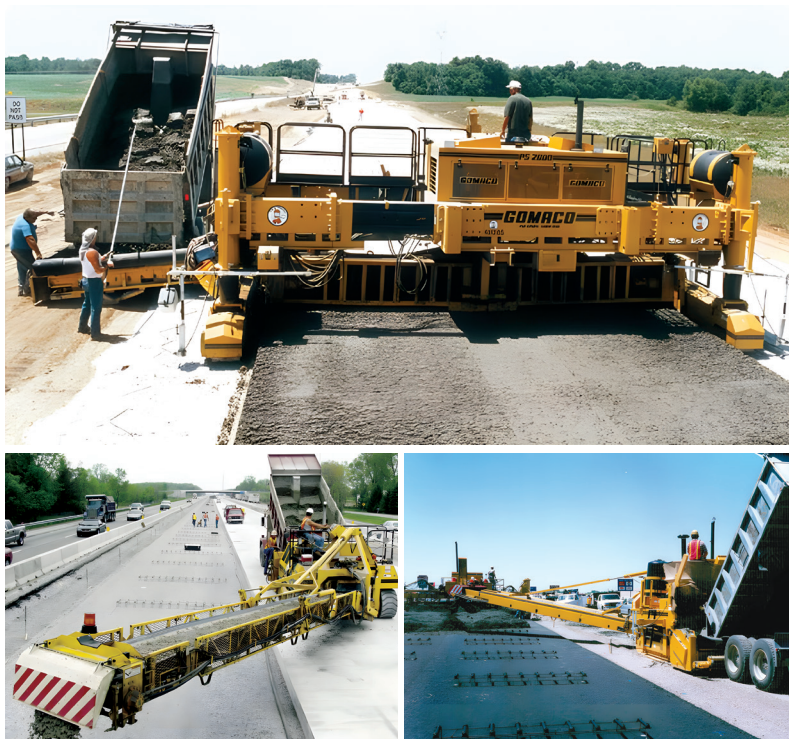
Рис. 5, 6 и 7. Примеры боковой разгрузки бетонной смеси
