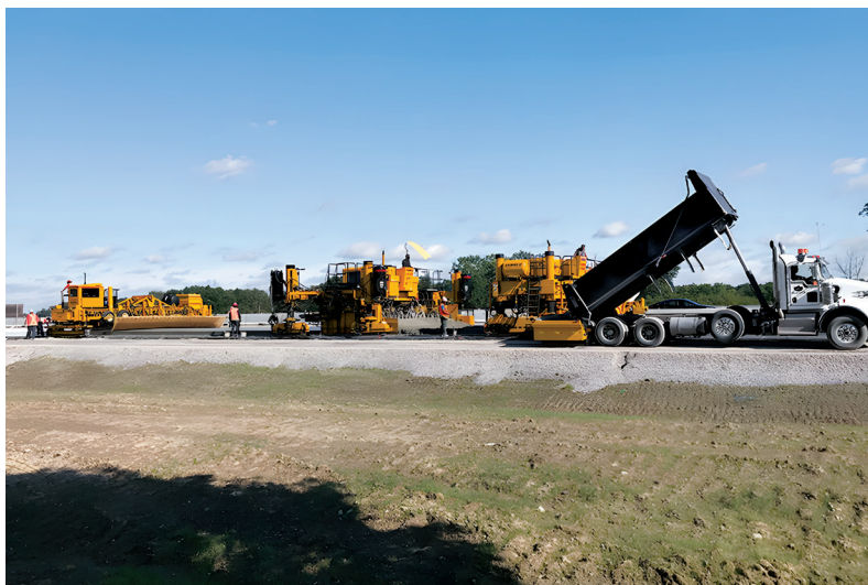
Рис. 12. Строительство автомагистрали в провинции Онтарิโอ (Канада) бетоноукладочным комплексом в составе PS2600, GP3, TC600
