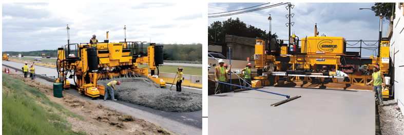
Рис. 4. Строительство автодороги в штате Пенсильвания (США)
