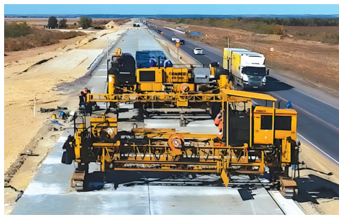
Рис. 11. Выглаживающий рабочий орган Auto Float, предназначенный для автоматической окончательной отделки поверхности свежеложенного слоя бетона
