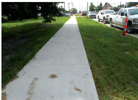
Рис. 7. Тротуары и пешеходные дорожки из цементобетона
