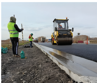
Рис. 10. Обработка гидрофобизатором Лепта 300 искусственных бетонных сооружений
