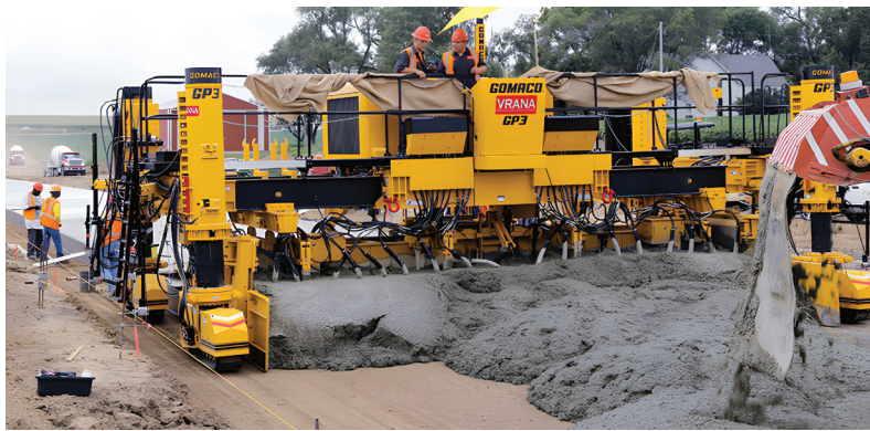
Рис. 1. Строительство автодороги в штате Небраска (США) с применением бетоноукладчика GP3
