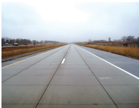
Рис. 16. Перекрытие слоем цементобетона по технологии Whitetopping и качественная заделка швов на автомагистрали в штате Миннесота (США)
