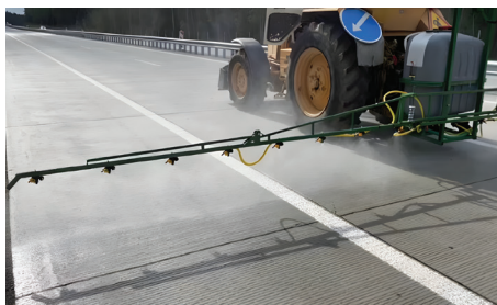
Рис. 9. Обработка гидрофобизатором Лепта 300 дорожного цементобетонного покрытия
