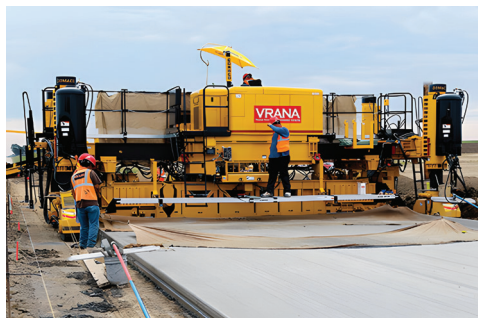
Рис. 2. Строительство автодороги в штате Небраска (США) с применением бетоноукладчика GP3
