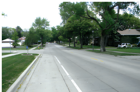
Рис. 14. Улица с цементобетонным покрытием в г. Ломбарде, штат Иллинойс США (2003 год)
