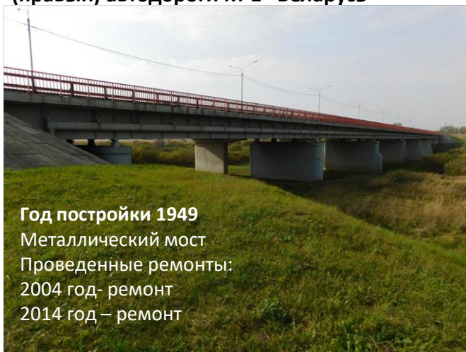
Мост через р. Днепр на км 281+200 (правый) автодороги М-1 "Беларусь"
