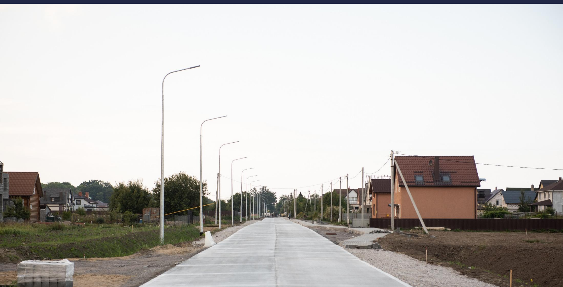
Автомобильная дорога «Вишневое-Сосновка-Вербное-Гусево», Калининградская область
