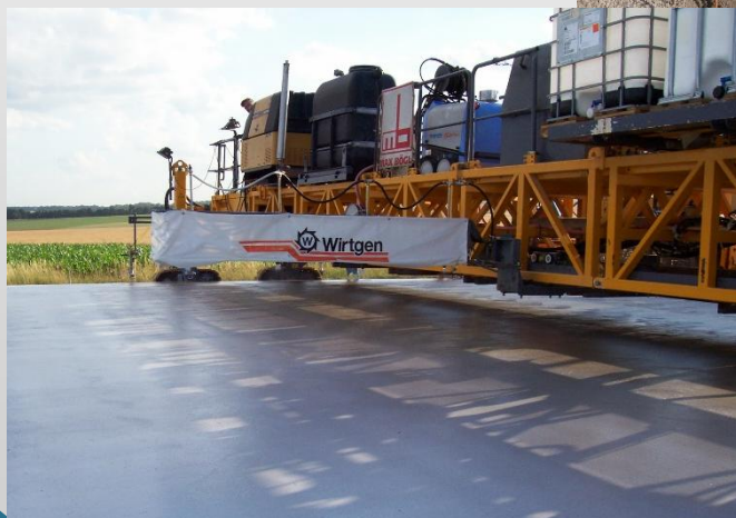
1-е: Распыление состава для замедления твердения поверхностного слоя бетона
