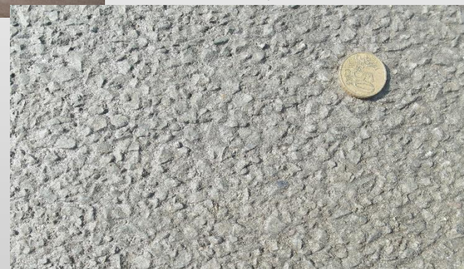
3-е: Поверхность с «открытым заполнителем» (глубина 1-2 мм) → после: нанесение плёнообразующего состава
