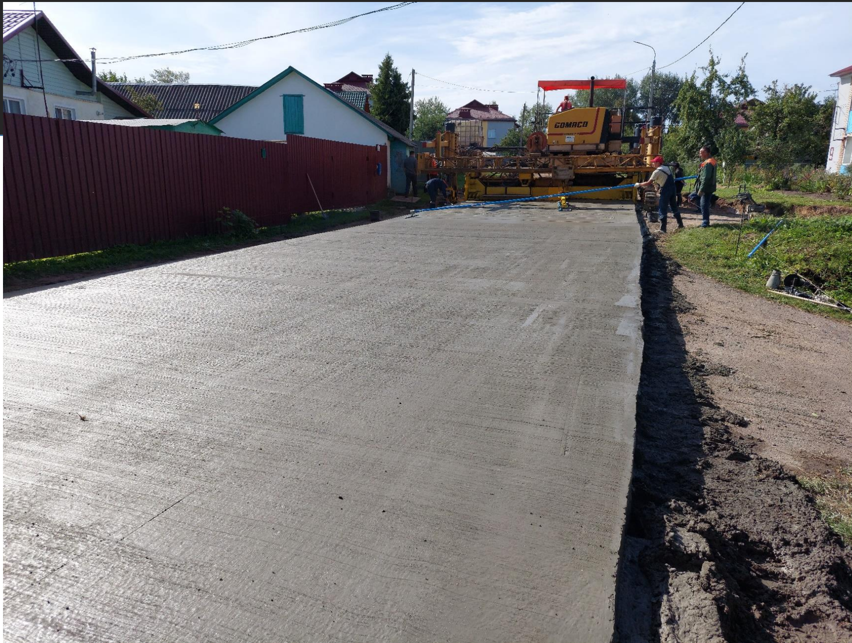
Укладка покрытия на местной автодороге
