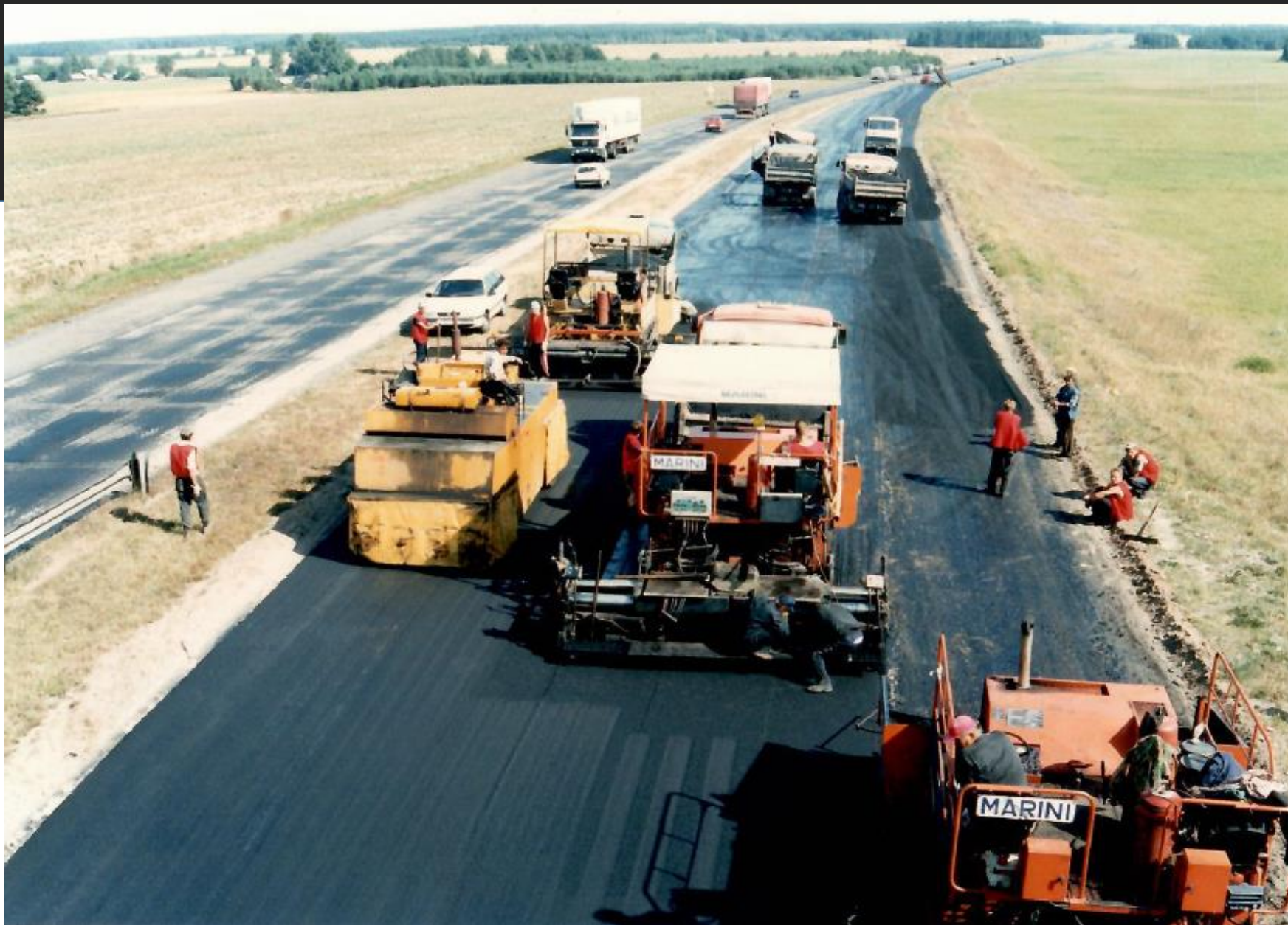
Укладка нового асфальтобетонного покрытия
