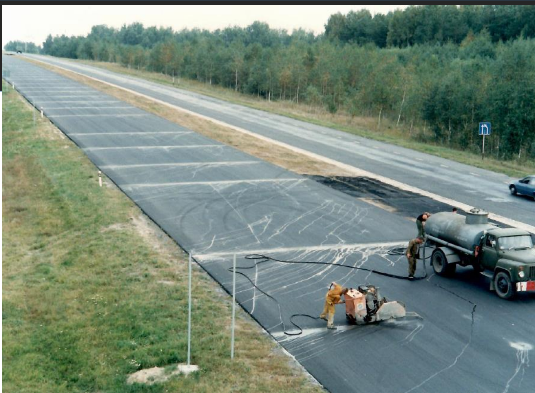
Нарезка швов в асфальтобетонном покрытии над существующими швами старого цементобетона
