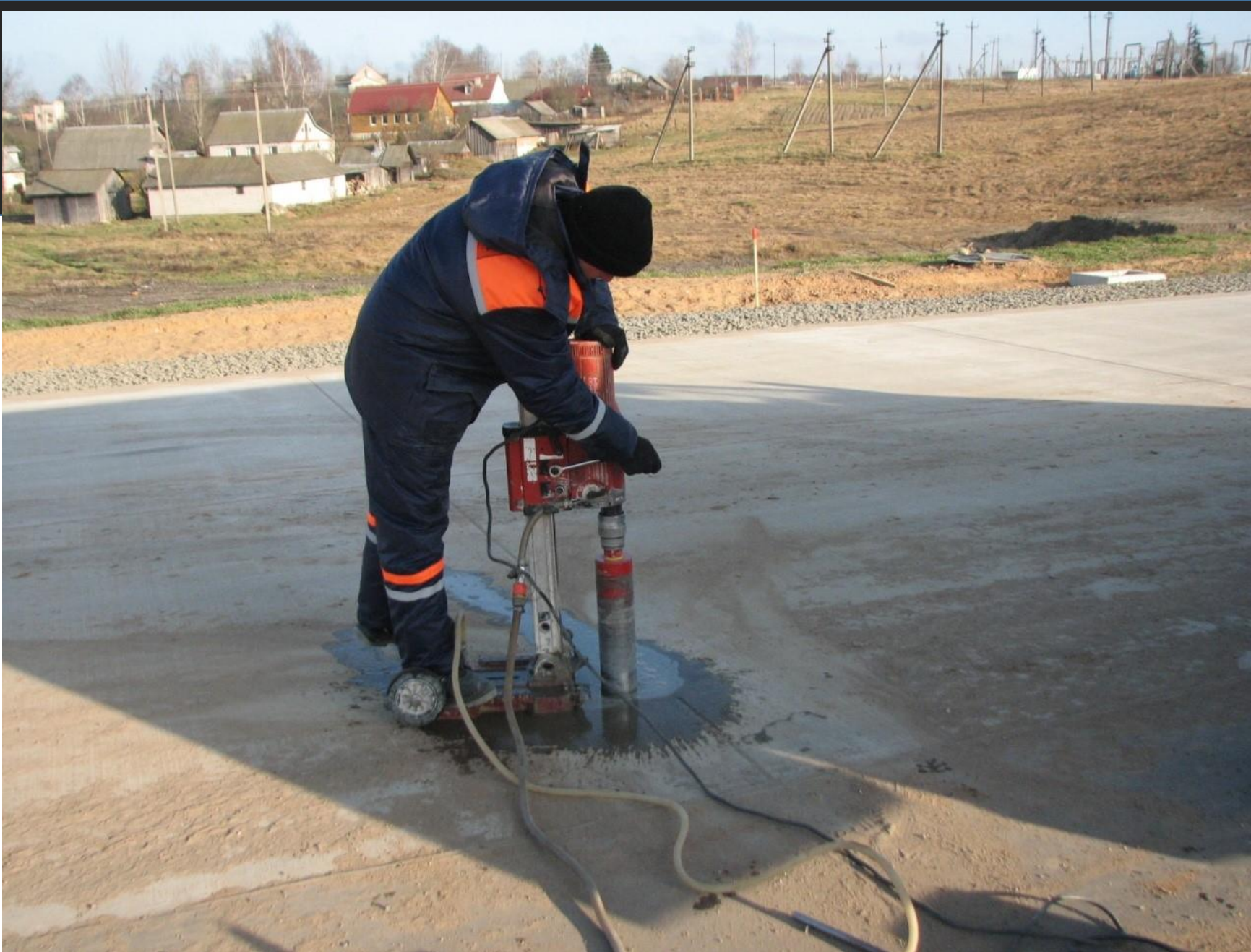
Отбор кернов для лабораторных испытаний
