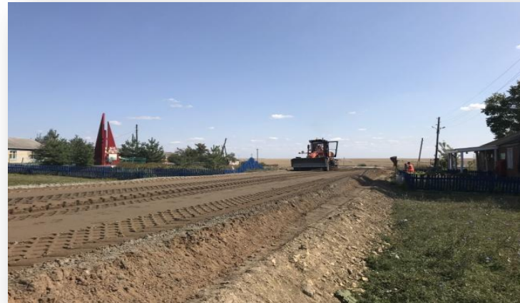
Планировка готовой смеси
