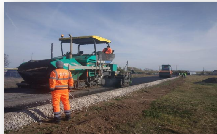
Укладка асфальтобетона
