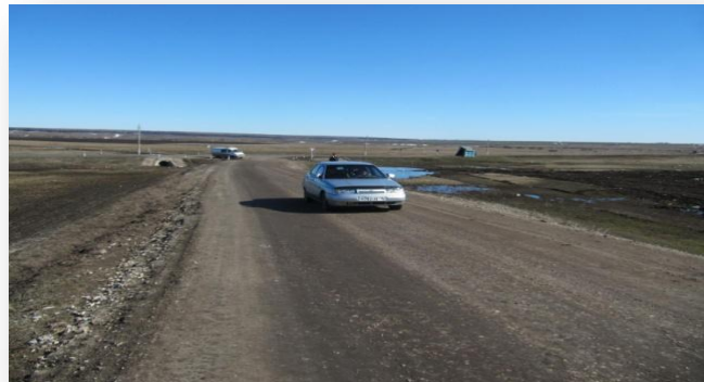
Состояние участков автомобильной дороги (после года эксплуатации)
