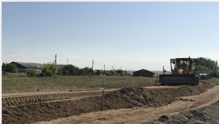
Распределение песка автогрейдером
