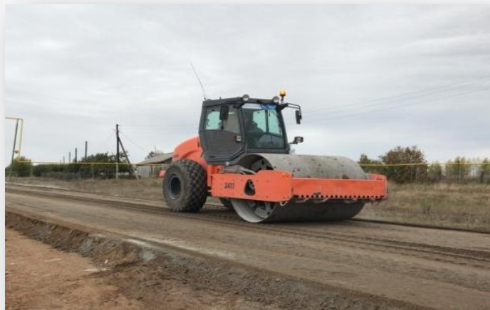
Уплотнение готовой смеси
