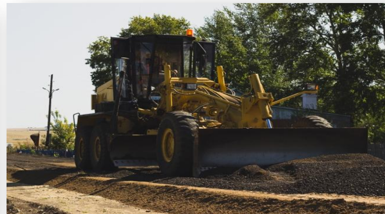
Распределение асфальтогранулята автогрейдером
