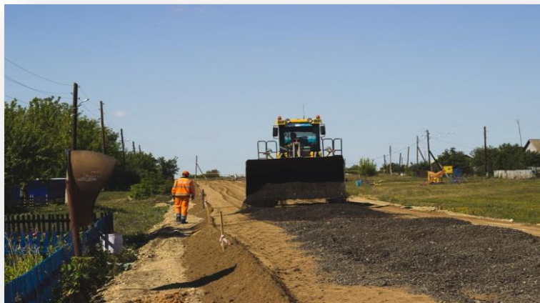
Подвоз асфальтогранулята погрузчиком
