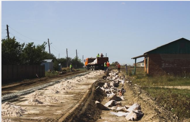
Внесение активированных минеральных наполнителей, распределение автогрейдером (участок 3,4)
