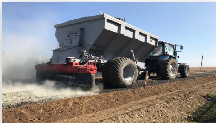
Распределение цемента цементораспределителем
