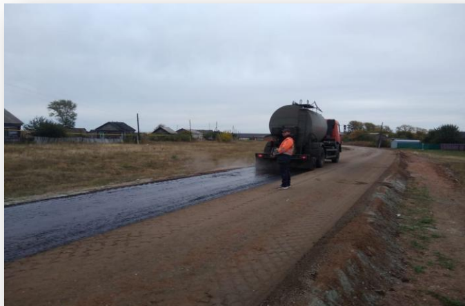
Розлив битумной эмульсии автогудронатором
