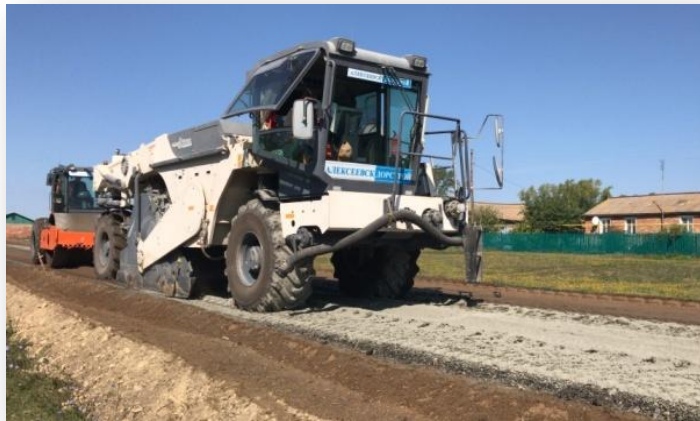
Смешение компонентов ресайклером с последующим уплотнением катком
