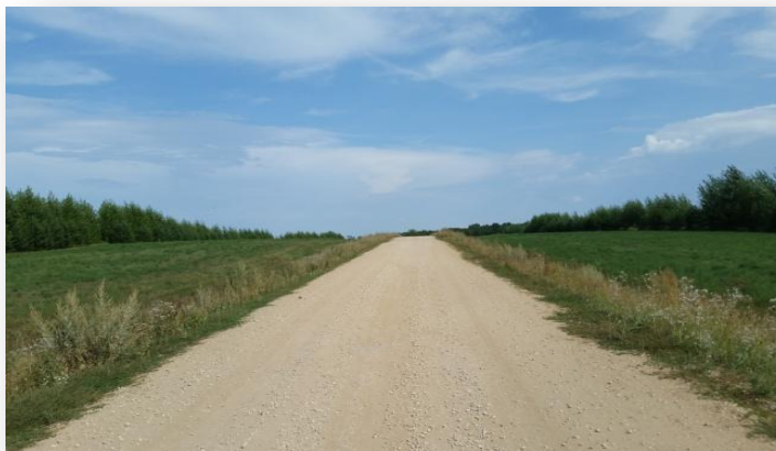
Состояние участков автомобильной дороги (после года эксплуатации)
