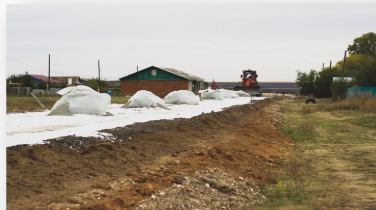
Распределение фиброволокна автогрейдером (участок 2)
