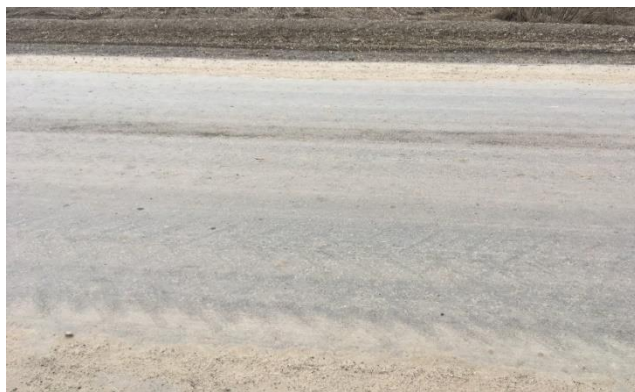
Основание, регенерированное с комплексным минеральным вяжущим
