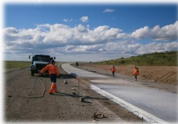
Контроль нарезки швов
