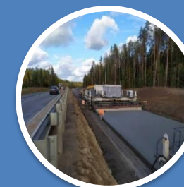
Автомобильная дорога М3 Минск - Витебск, км 8,6 - км 87,95; III очередь, км 41,0 - км 56,0.
