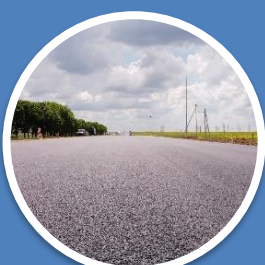
Автомобильная дорога Р-23 Минск – Микашевичи, км 74,0 – км 126,3 I Вочередь, км 102,0 – км 110,7
