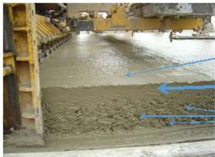
Проблемы при укладке бетонной смеси
