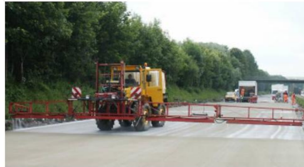
Нанесение кюринга (плёнкообразующего слоя)
