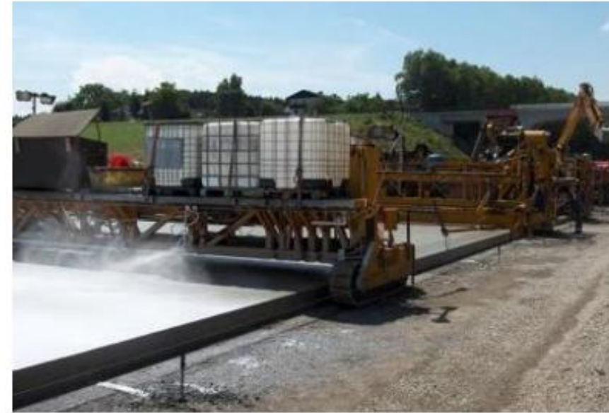
Нанесение комбинированного средства ( замедлитель+кюринг )
