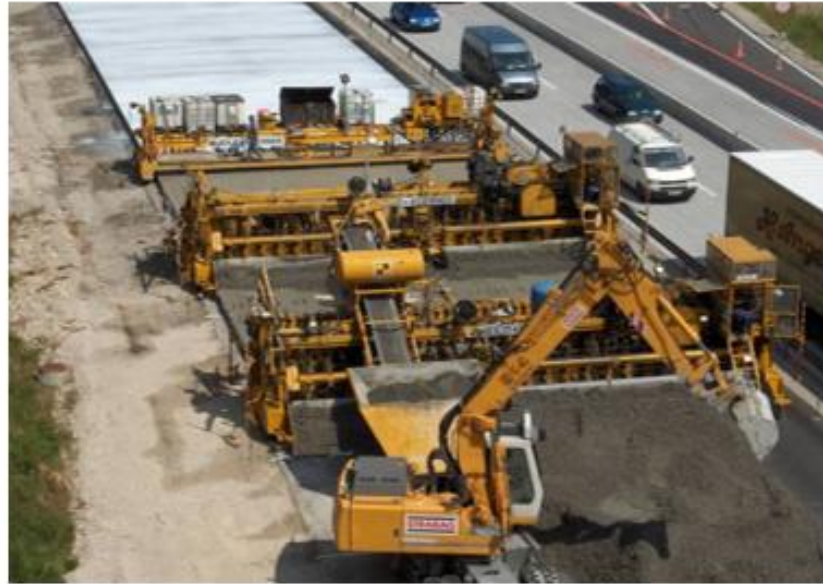
Устройство 2-слойного цементобетонного покрытия
