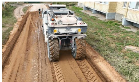
Смешение цементогрунта ресайклером с увлажнением и введением водорастворимых модификаторов
