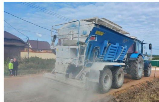
Распределение цемента цементораспределителем
