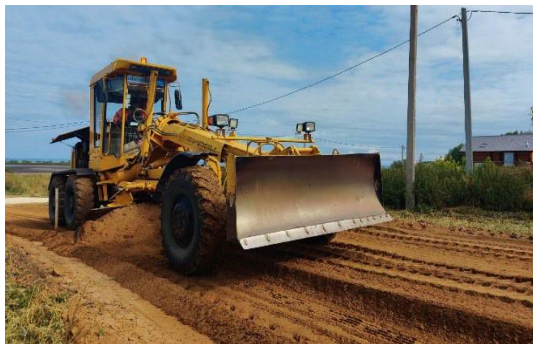
Подвоз и распределение грунта
