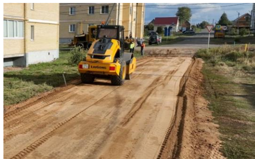
Уплотнение слоя основания
