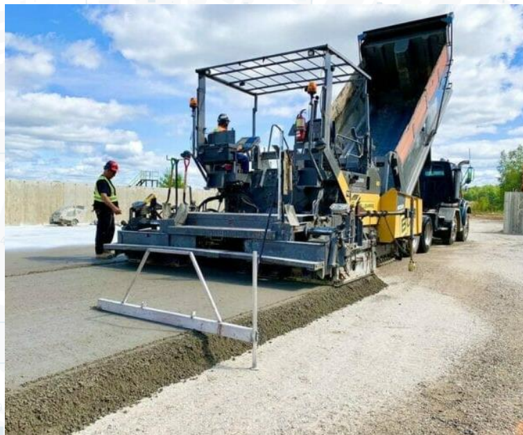
Строительство бетонных оснований асфальтоукладчиками (укатываемый бетон)
