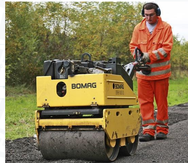
Строительство бетонных оснований и покрытий вручную с применением средств малой механизации
