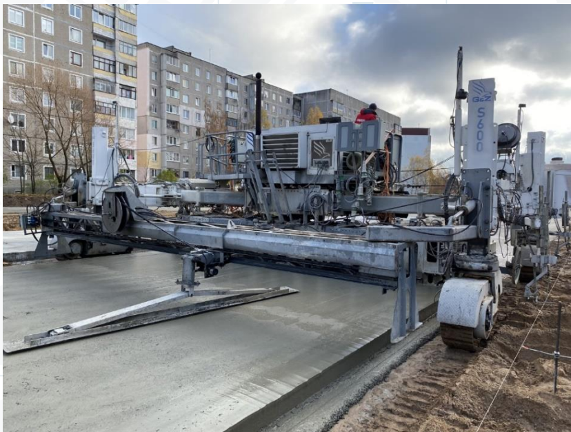
Устройство однослойных покрытий и оснований, а также двухслойных покрытий бетоноукладчиками со скользящими формами
