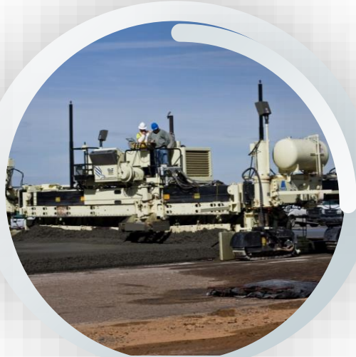
Бетоноукладочный комплект Gunter & Zimmerman S850 (ширина укладки от 3 до 9,5 м., толщина до 0,45 м. с системой DBI)
