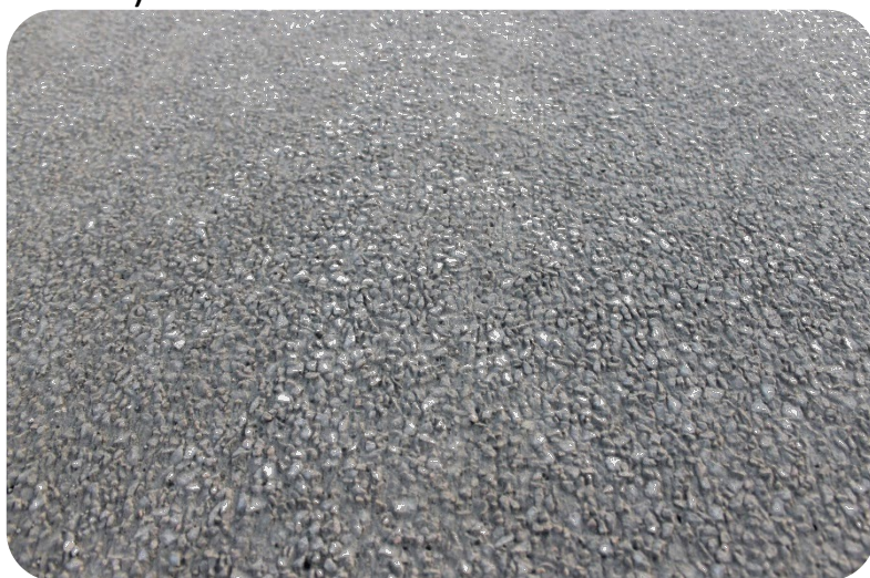
Текстура поверхности покрытия при технологии «мытый бетон»
