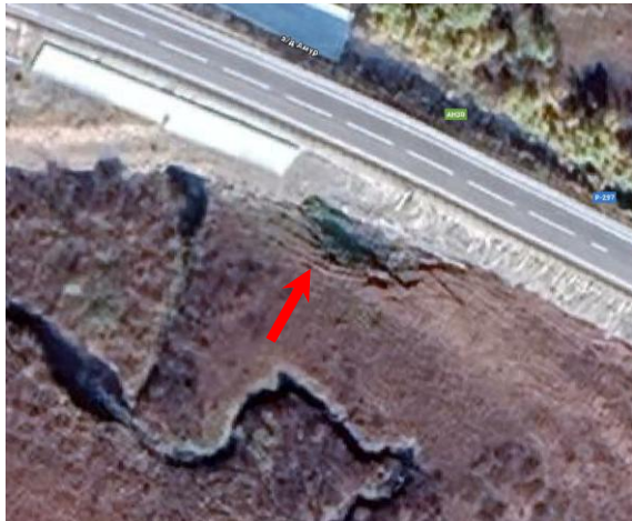
Трещины отседания, свидетельствующие о развитии термокарста
