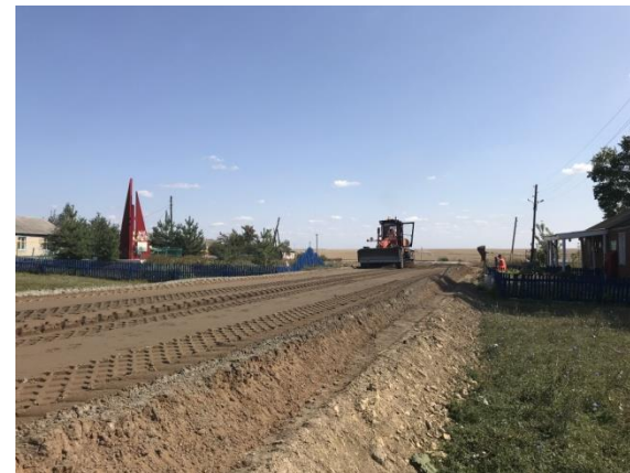
Планировка готовой смеси
