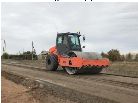
Уплотнение готовой смеси
