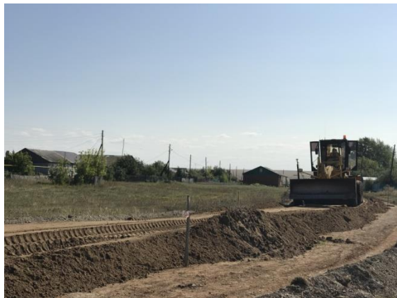
Распределение песка автогрейдером
