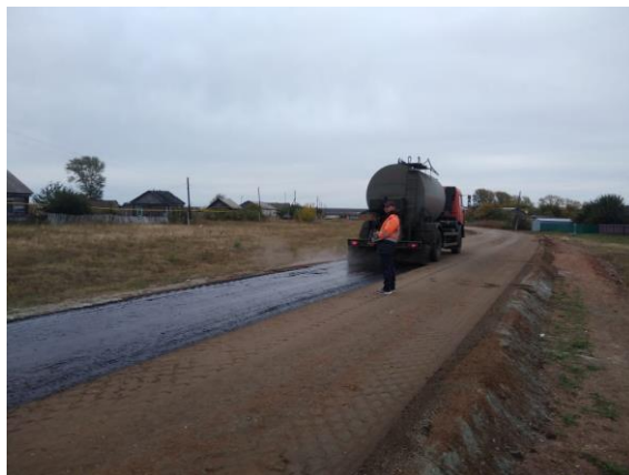
Розлив битумной эмульсии автогудронатором
