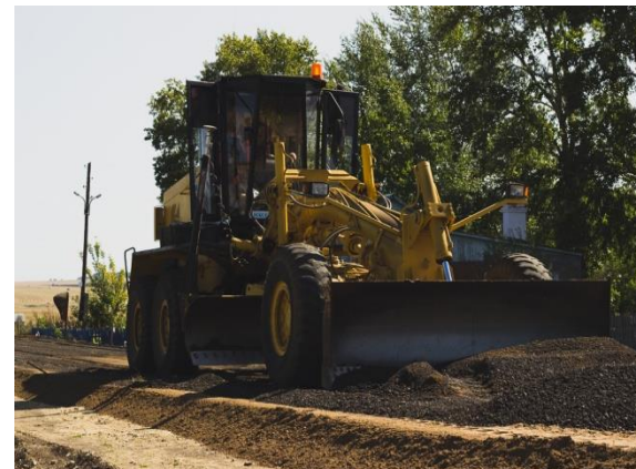
Распределение асфальтогранулята автогрейдером
