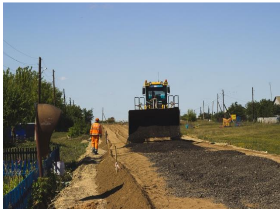
Подвоз асфальтогранулята погрузчиком
