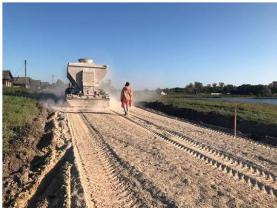
Внесение активированных минеральных наполнителей цементораспределителем (участок 3,4)
