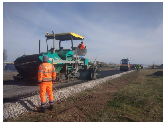
Укладка асфальтобетона
