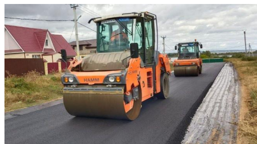
Укладка верхнего слоя покрытия
