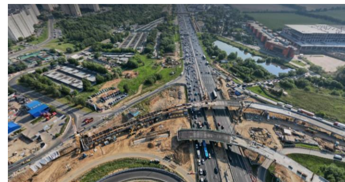
Реконструкция транспортной развязки на пересечении МКАД и ул. Липецкой (Приведение опор в проектный размер)
