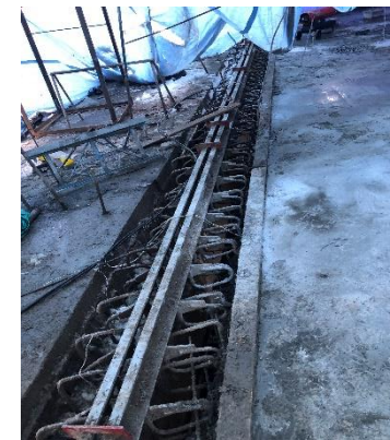
г. Вязьма, 227-й км трассы М-1 Беларусь (омоноличивание деформационных швов)
