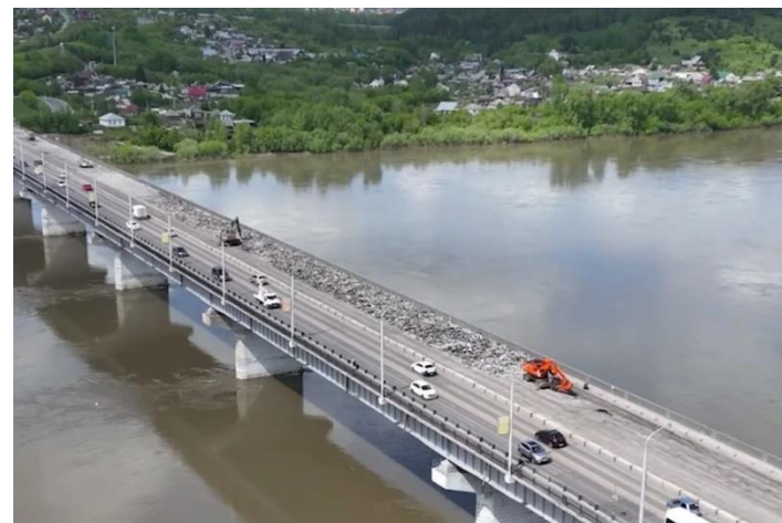
Кузбасский мост г. Кемерово (Омоноличивание дефшвов мостовых конструкций при реконструкции)
