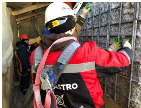
Крымский мост г.г. Керчь-Тамань (Ремонт опоры и ригеля)
