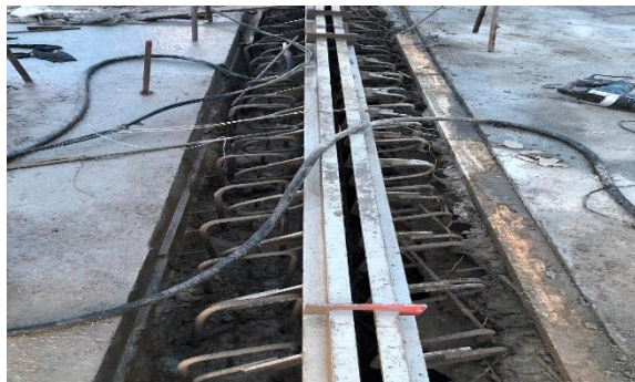
г. Вязьма, 227-й км трассы М-1 Беларусь (омоноличивание деформационных швов)
