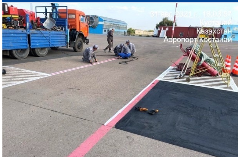
НАНЕСЕНИЕ СОСТАВА «БРИТ» ЗВС-Р, АЭРОПОРТ «КОСТАНАЙ», 2021 Г.
