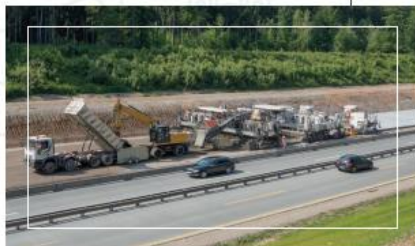
АВТОМОБИЛЬНАЯ ДОРОГА Г. МИРНЫЙ
