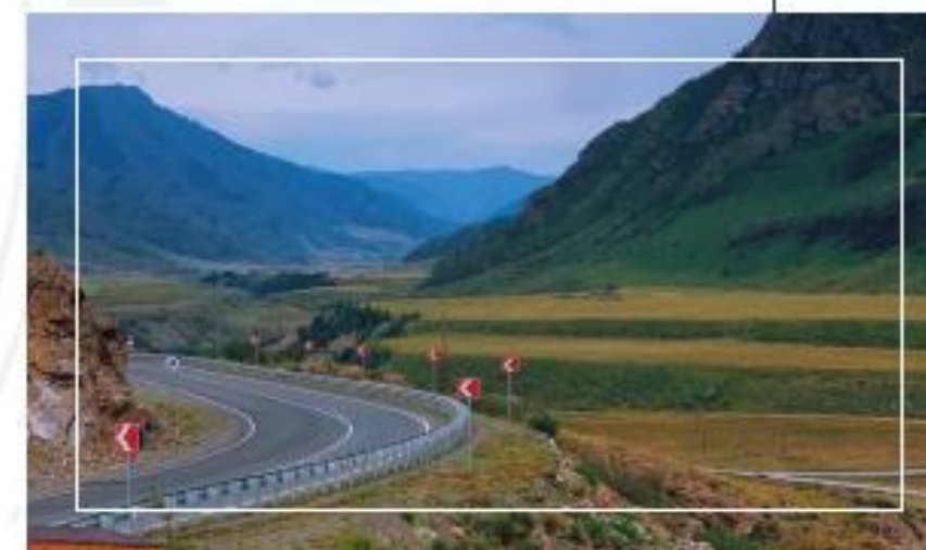
АВТОМОБИЛЬНАЯ ДОРОГА М-52 «ЧУЙСКИЙ ТРАКТ»
