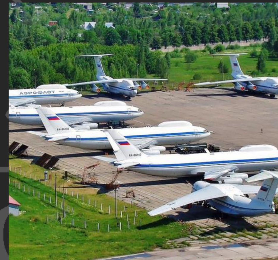
2016 год ГЕН.ПОДРЯД НА СТРОИТЕЛЬСТВО ПЕРРОНА ЧКАЛОВСКОГО АЭРОДРОМА
