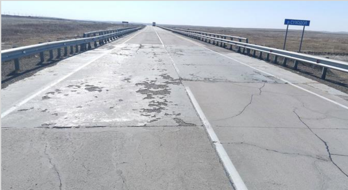
Шелушение покрытия
