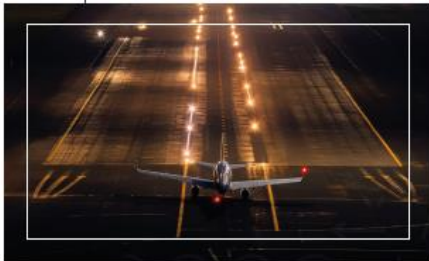
АЭРОДРОМ ПЛЕСЕЦК (ПРОДОЛЖЕНИЕ СТРОИТЕЛЬСТВА)
