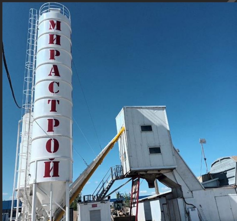
2015 год ПРОИЗВОДСТВО БЕТОНА И СТРОИТЕЛЬСТВО
