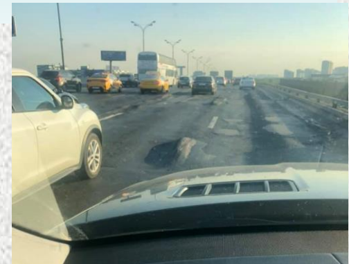
Эстакада на Ленинском пр. в г. Москве (июль 2021 г.)
