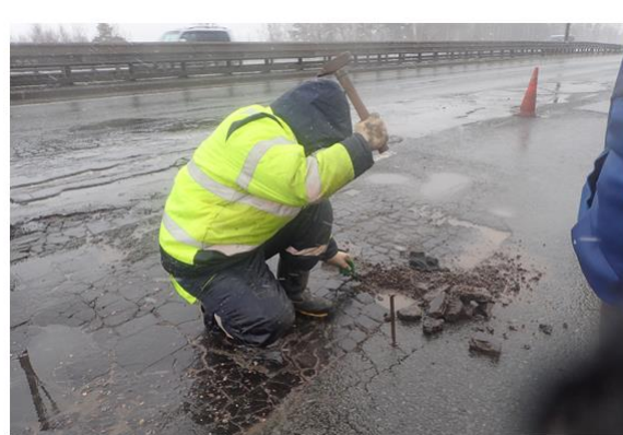
Фото 5. Вскрытие разрушенного покрытия после ямочного ремонта.
