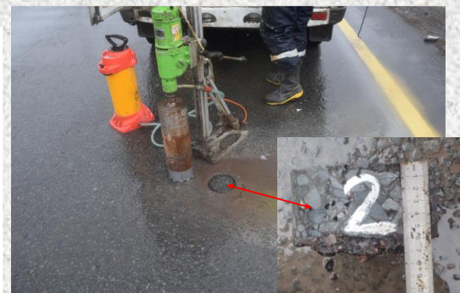
Фото 6. Отбор асфальтобетонных кернов из покрытия. Толщина верхнего слоя – 6,5 см
