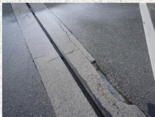
Стыки в зоне парапетов
