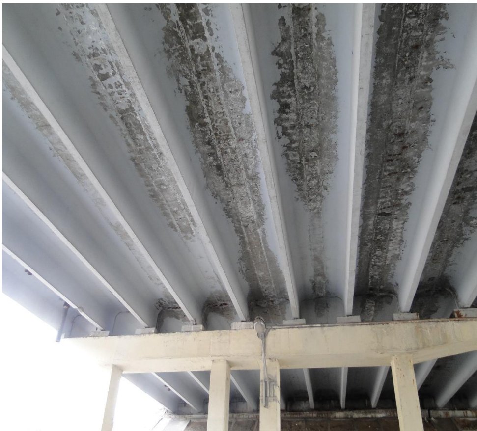
Путепровод на а.д. М-9 МКАД, км 9,114
