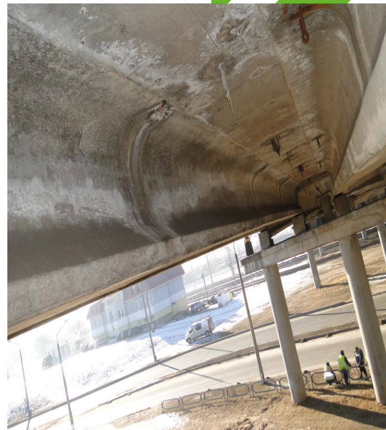
Путепровод по ул. Гагарина в г. Бобруйск
