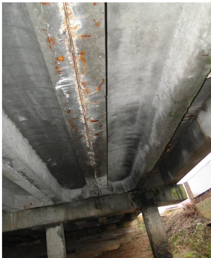
Мост через р. Щара на а.д. Н-794 Ляховичи – Кривошин – Святица, км 4,258
